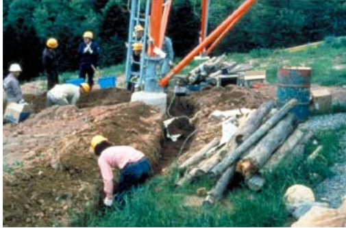
Excavación para la conexión a tierra de SAN-EARTH
